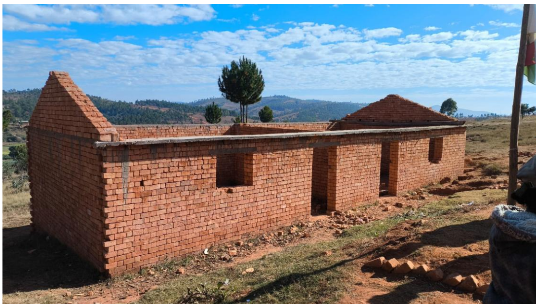
Figure 6 : Murs de la nouvelle classe achevés, chaînage en béton posé.
